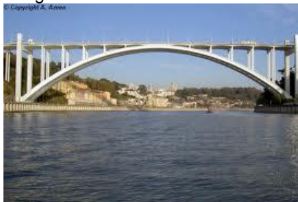
Imagem 1 – Ponte de arco
