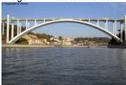
Imagem 1 – Ponte de arco
