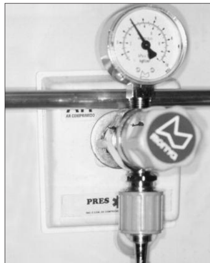
Figura 3. Instalação da mangueira condutora de ar do equipamento odontológico portátil acoplada ao ar comprimido da sala do centro cirúrgico
